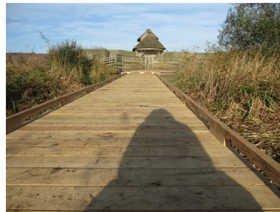
En cours de construction
